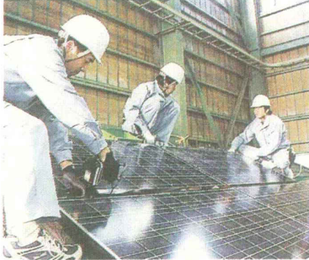
太陽光パネルの設置研修を受ける受講生。埼玉県玉川口市の太陽光発電工事専門校の研修所
